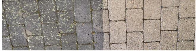
Biobelag wird entfernt und anschl. die Verwitterung + Schutz
